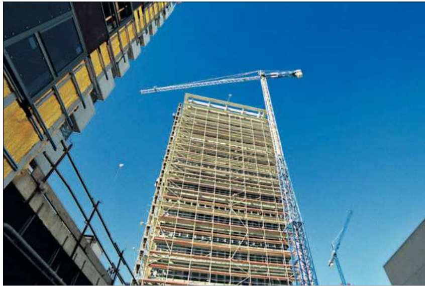
Edificio en construcción. THINKSTOCK
