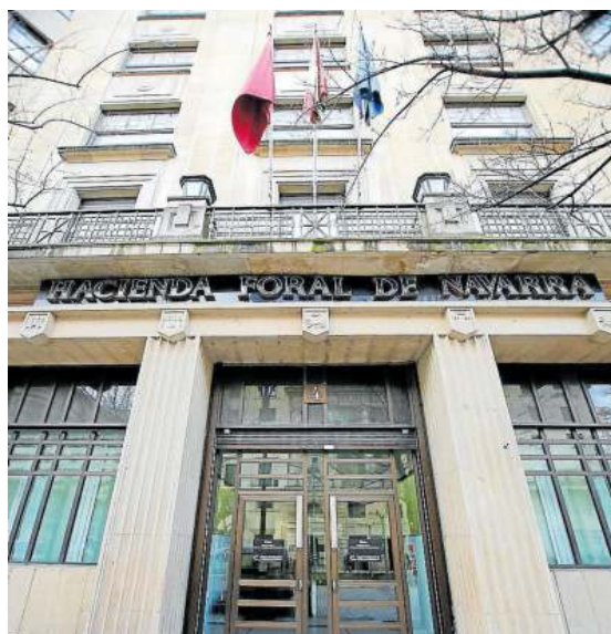
Edificio de Hacienda Foral de Navarra en Pamplona.
